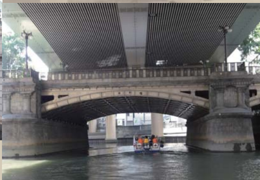
大阪・本町橋
